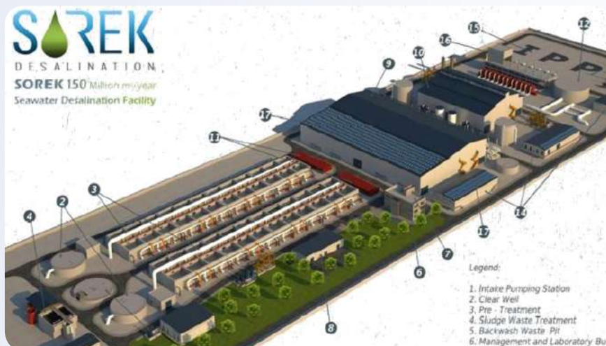
מתקן התפלה בשורק / גן רווה פרויקט מתקן התפלה בשורק / גן רווה : מייצר כ - 150 מיליון קוב מים בשנה
